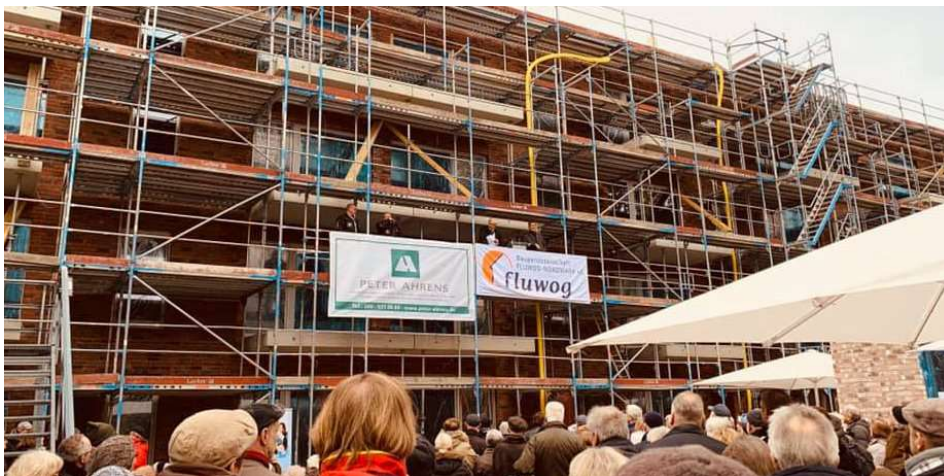
Richtfest bei der FLUWOG am Vielohweg
